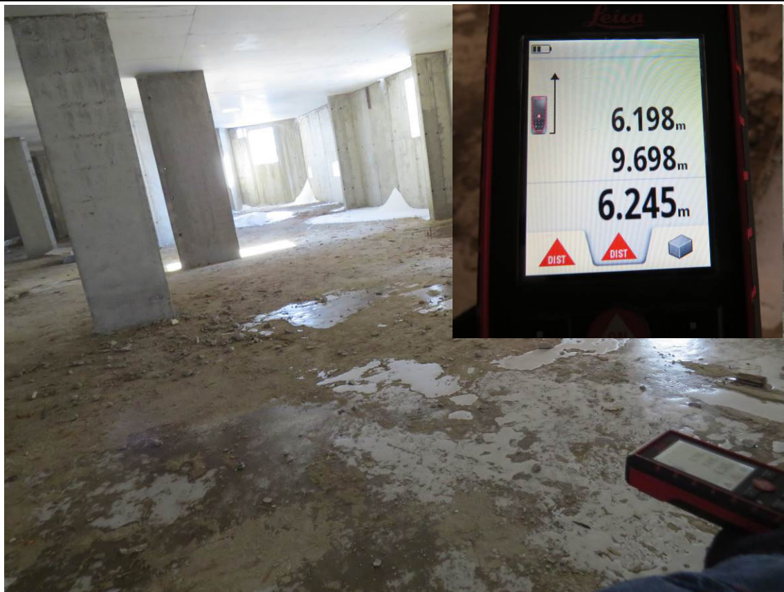
Рис. 3.2.4. Замер шага пилонов на отм. -3,400 м
