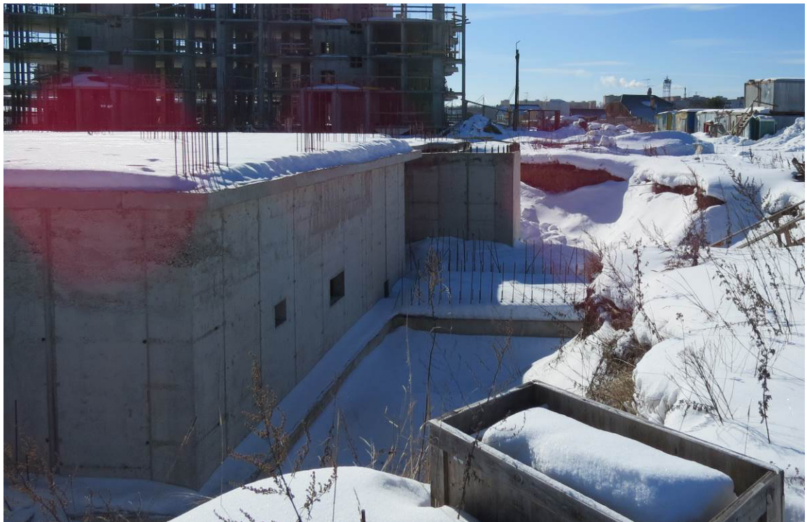
Рис. 1.2. Общий вид смонтированных конструкций по оси 1 жилого дома №23
