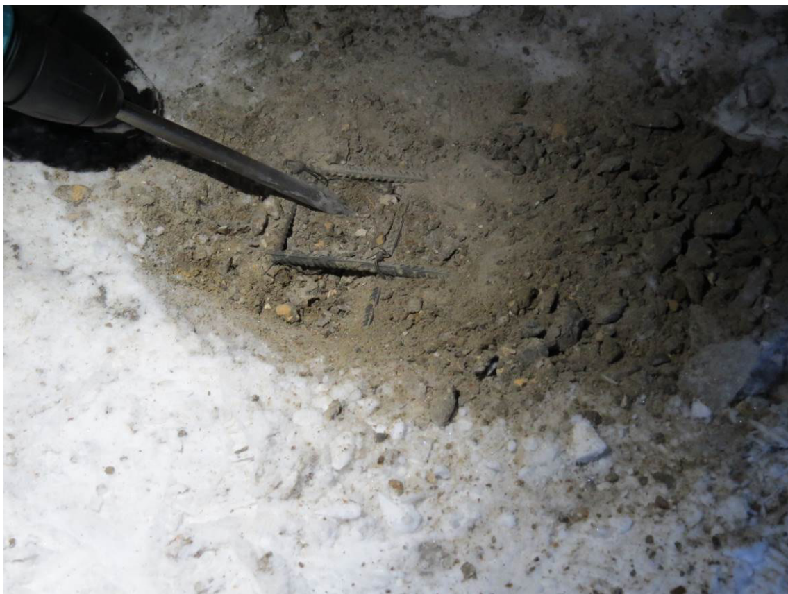
Рис. 3.3.4. Общий вид участка вскрытия монолитной ж.б. плиты перекрытия подвала между осями А-Б/25-27 (зона верхнего армирования)
