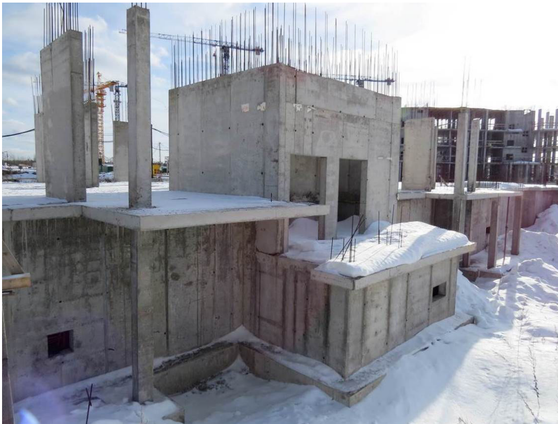
Рис. 3.2.1. Общий вид монолитных ж.б. колонн и стен на отм -3.400 и -0.100 м
