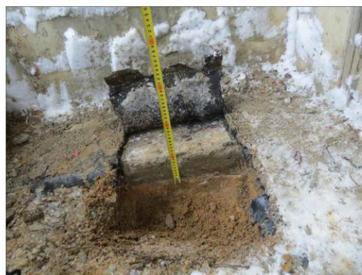
ФОТО 5. Уточнение толщины бетонной подготовки шурфа №2 расположенного в осях А/15-16
