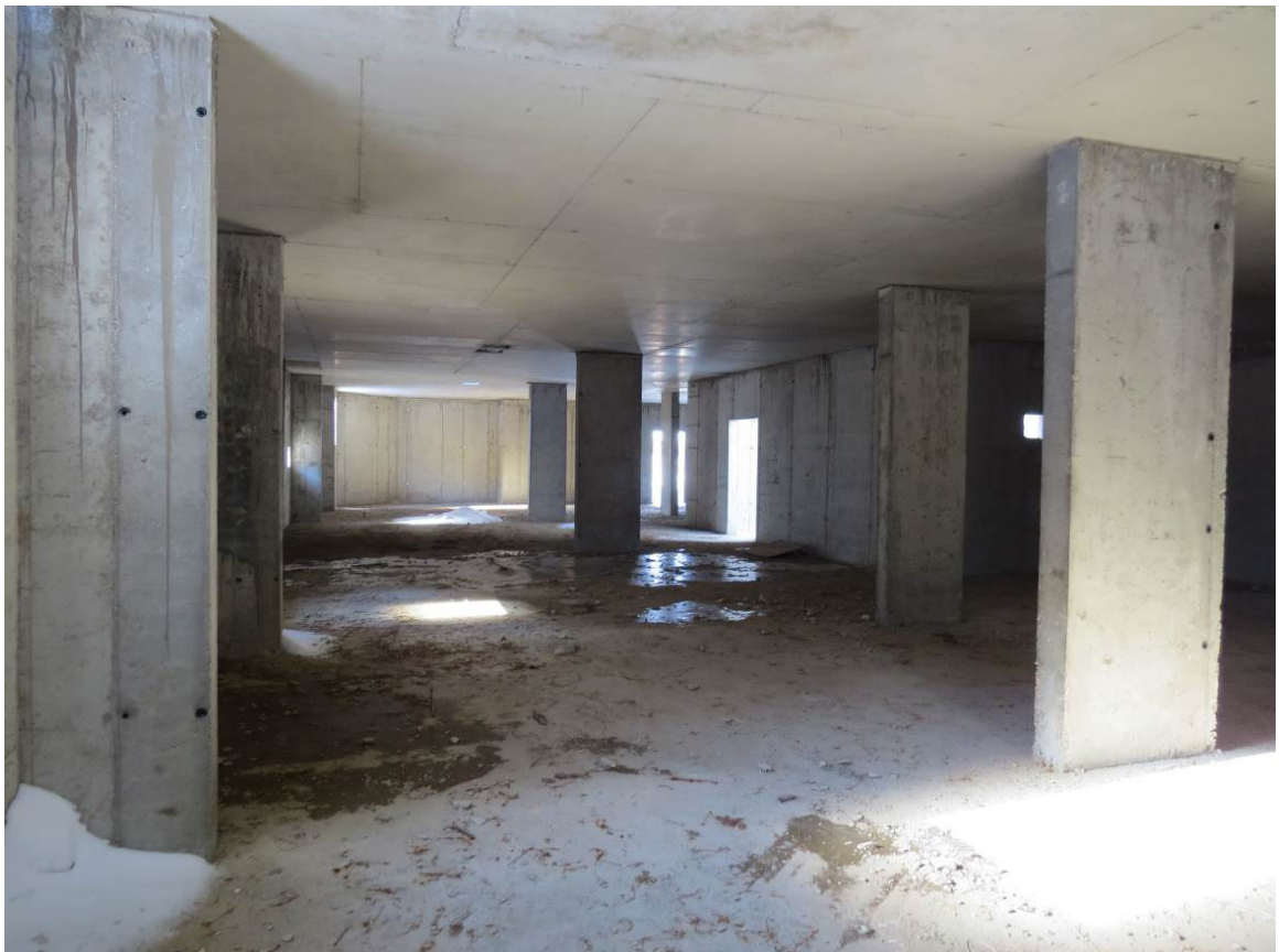
Рис. 1.4. Общий вид внутреннего пространства подвала жилого дома №23 между осями 10-1, Д-К
