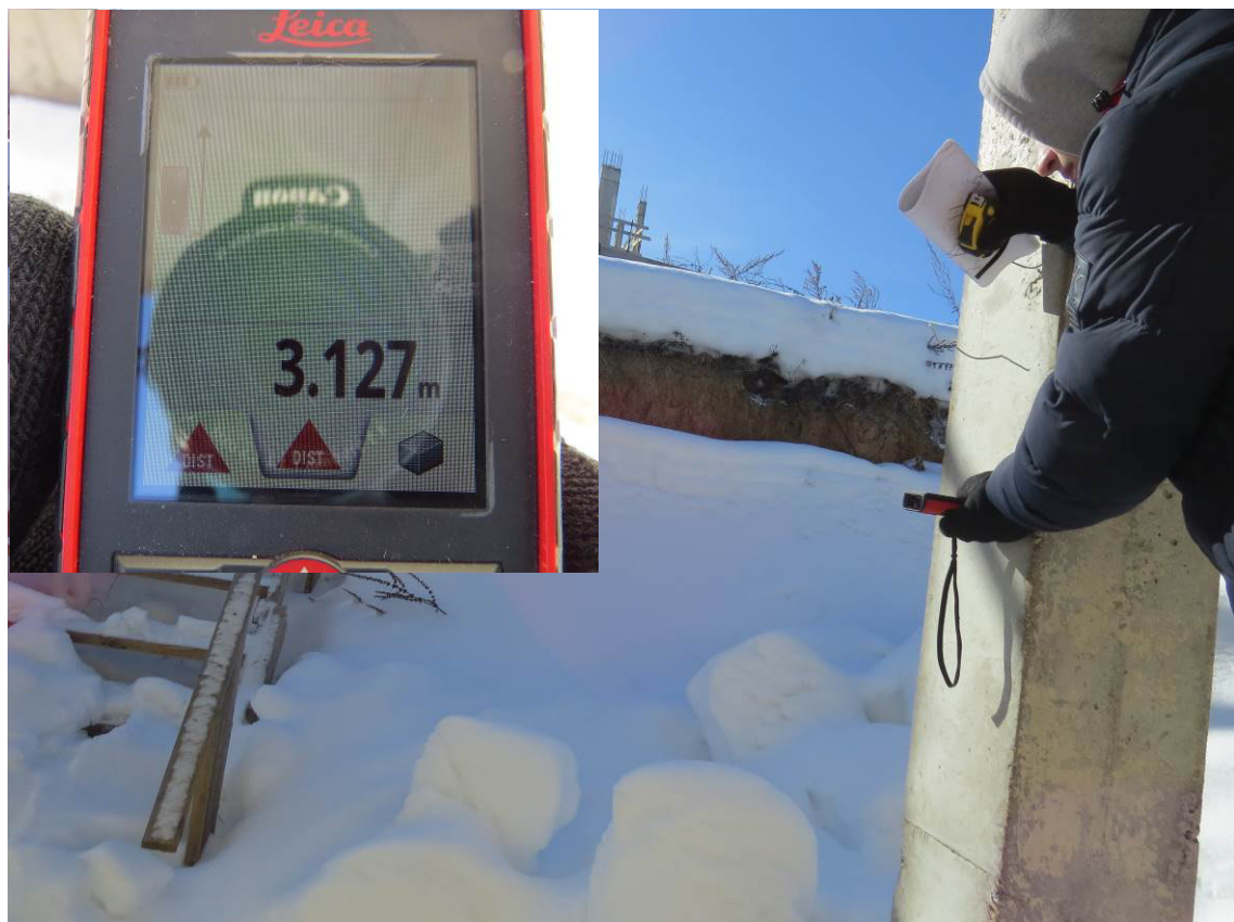
Рис. 3.2.5. Замер шага колонн на цокольного этажа по оси Д/3-9
