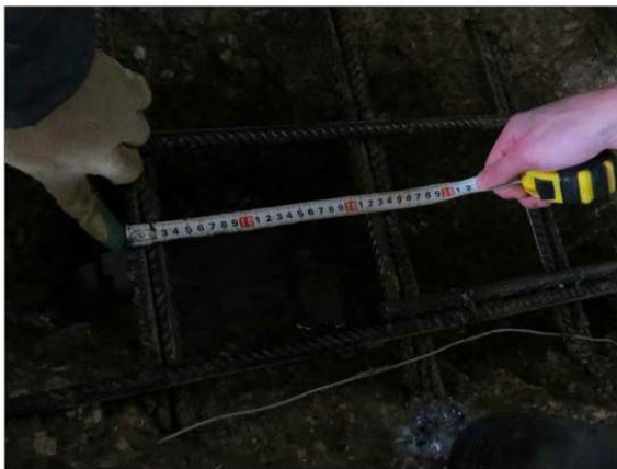
ФОТО 20. Общий вид вскрытия монолитной железобетонной плиты перекрытия подвала на отм. ниже ±0.000 между осей Ж/8-9 (горизонтальный шаг)
