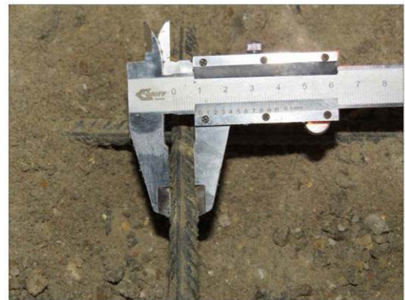
ФОТО 8. Уточнение диаметра арматуры монолитной железобетонной плиты перекрытия на отм.-0.100 в осях А-Б/25-26
