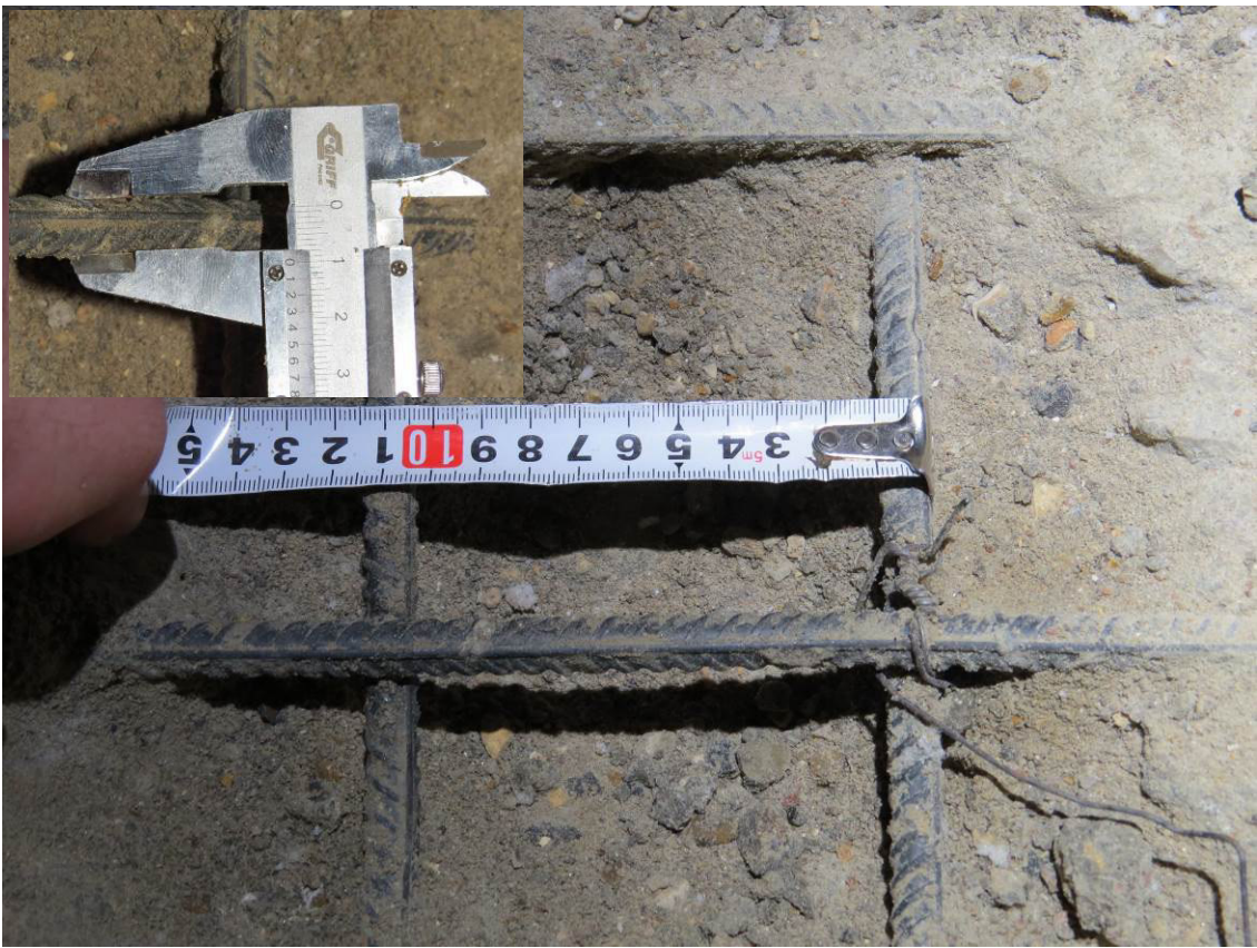
Рис. 3.3.5. Замер геометрических параметров верхнего армирования плиты перекрытия подвала между осями А-Б/25-27
