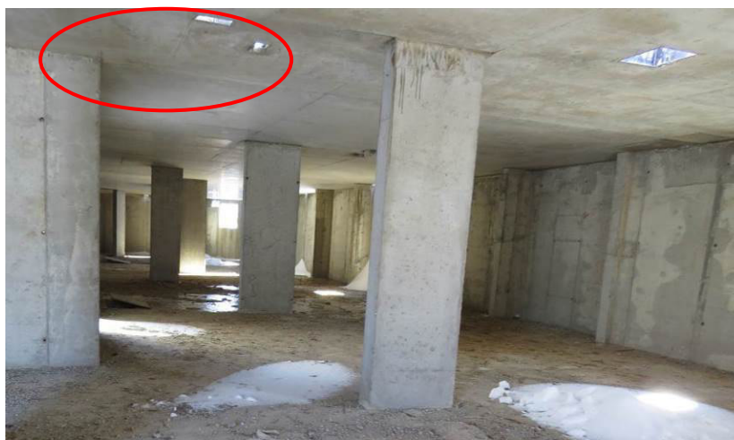
Рис. 3.3.9. Непроектное размещение технологического отверстия по оси З/Е-Ж
