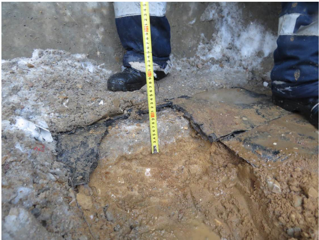
Рис. 3.1.4. Замер толщины бетонной подготовки в отрытом шурфе №1 секция 3 между осями 24-26 по оси Г
