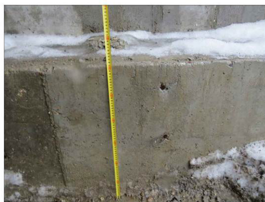
ФОТО 3. Уточнение толщины фундаментной плиты шурфа №1 расположенного в осях Г/24-26
