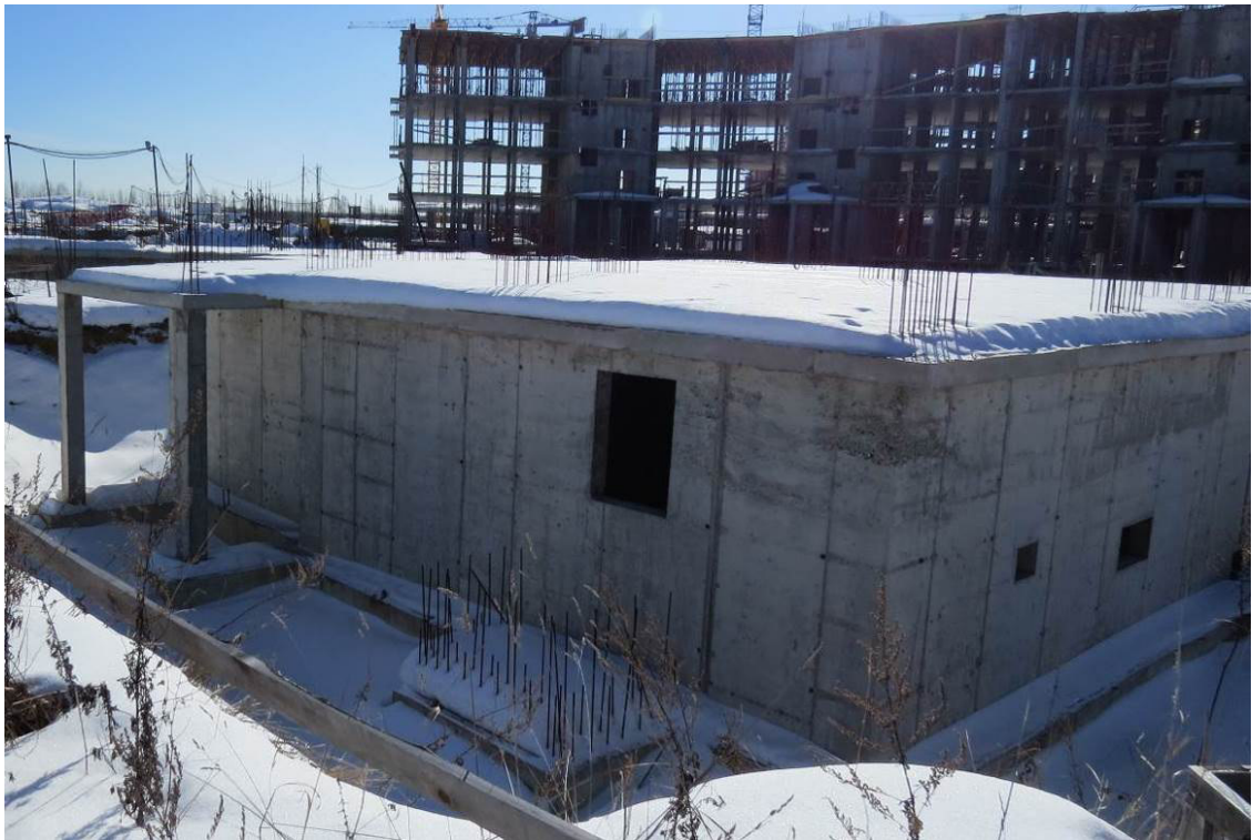
Рис. 1.1. Общий вид смонтированных конструкций по оси Н жилого дома №23
