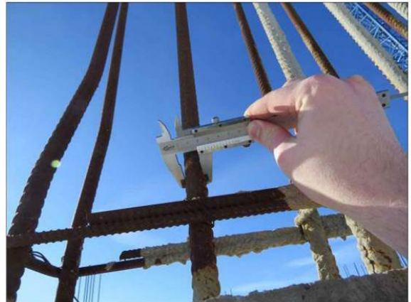
ФОТО 7. Уточнение диаметра арматуры монолитного железобетонного пилона на отм. выше ±0.000 на пересечении осей Б/25
