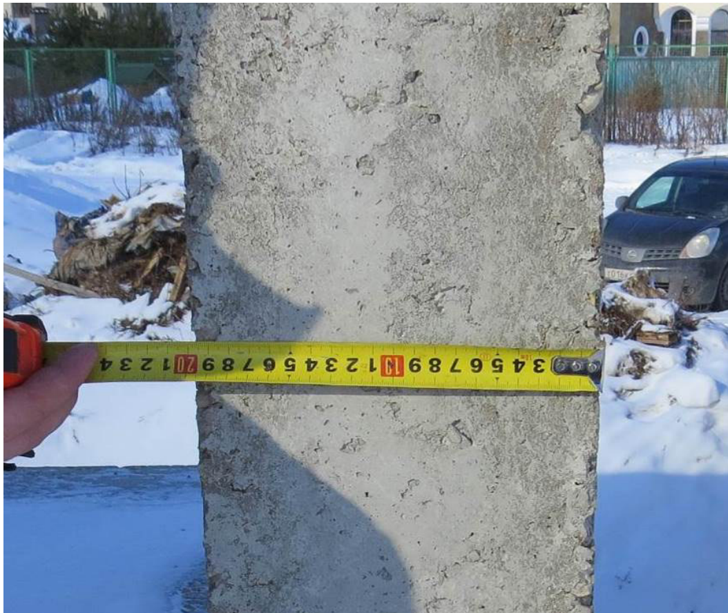
Рис. 2.1. Замер толщины монолитной ж.б. пилона при помощи металлической рулетки
