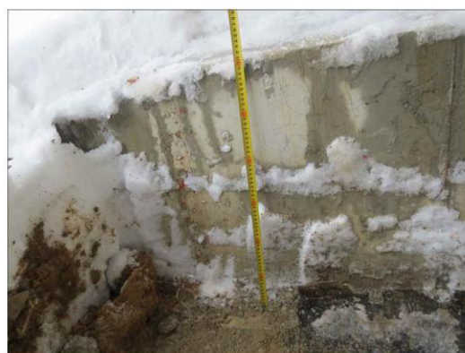
ФОТО 6. Уточнение толщины фундаментной плиты шурфа №2 расположенного в осях А/15-16
