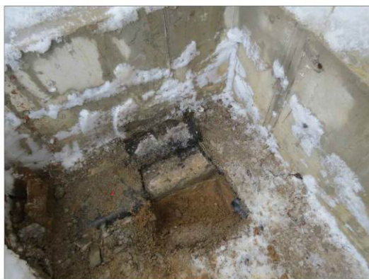
ФОТО 4. Общий вид внутреннего пространства шурфа №2 расположенного в осях А/15-16
