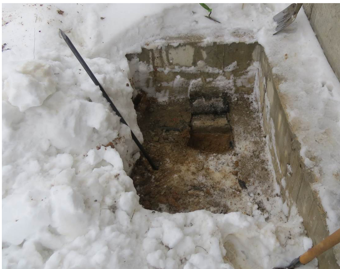
Рис. 3.1.2. Шурф №2 под наружную несущую монолитную ж.б. стену снаружи здания секция 2 между осями 16-17 по оси А
