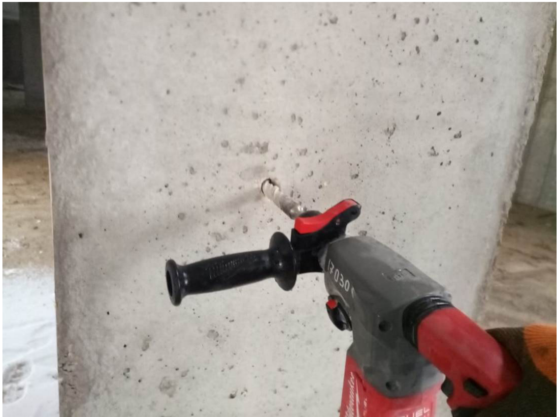
Рис. 4.2.1. Засверливание шпуров в монолитный пилон
