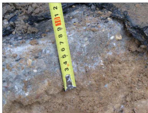
ФОТО 2. Уточнение толщины бетонной подготовки шурфа №1 расположенного в осях Г/24-26
