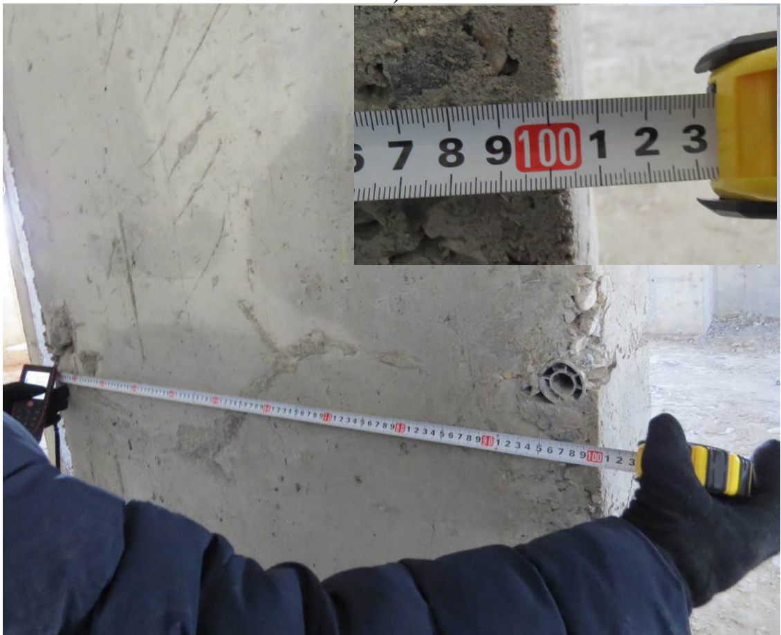
Рис. 3.2.3 (а, б) Замер сечения монолитного ж.б. пилона
