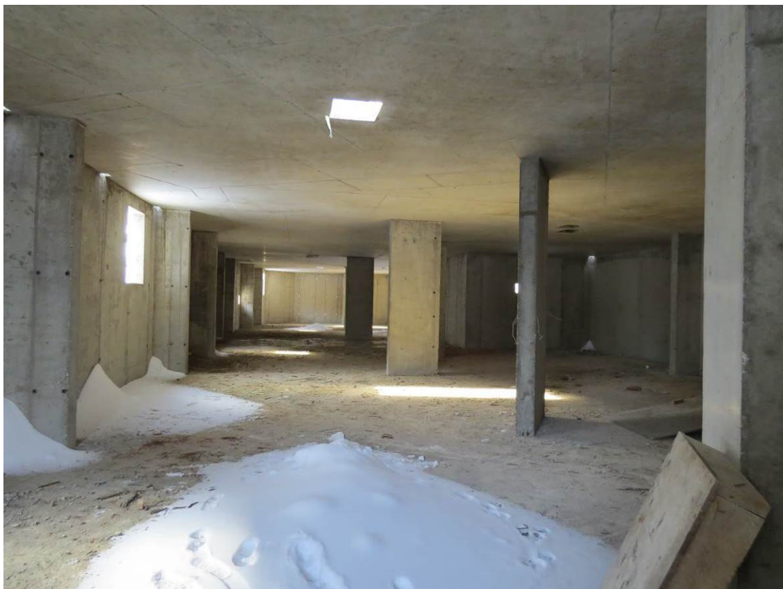
Рис. 3.3.2. Общий вид монолитной ж.б. плиты перекрытия в зоне подвального этажа в осях Д-Ж/1-11
