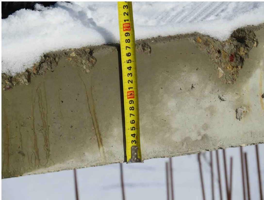
Рис. 2.2. Замер толщины плиты перекрытия 1-го этажа по оси А между осями 23-24
