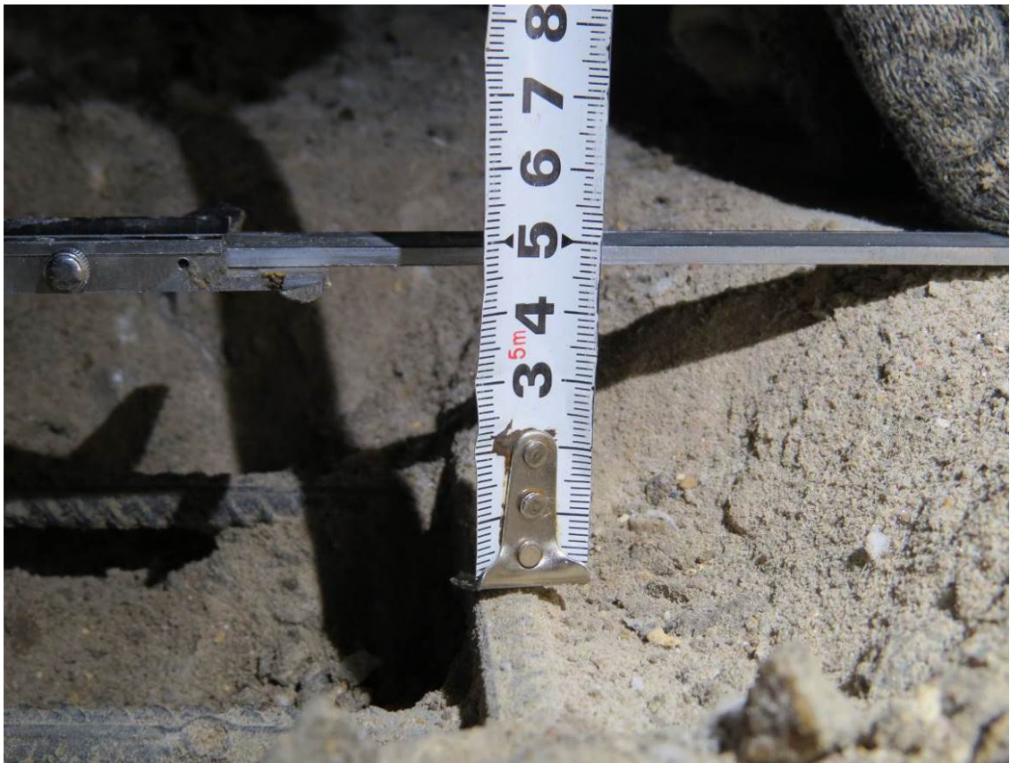
Рис. 3.3.6. Замер толщины защитного слоя бетона верхнего армирования плиты перекрытия подвала между осями А-Б/25-27
