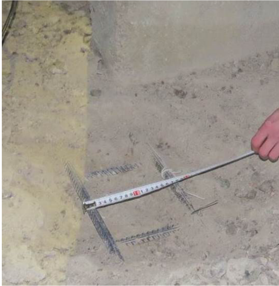
Рис. 3.1.5.Общий вид вскрытия фундаментной плиты секции 3 между осями 23-24 / А-Б
