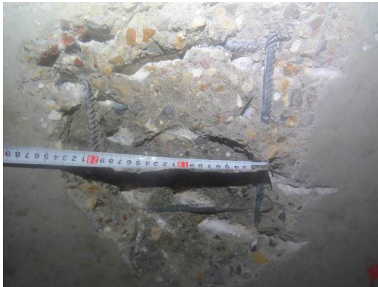
Рис. 3.3.7. Замер геометрических параметров нижнего армирования плиты перекрытия подвала между осями А-Б/22-25
