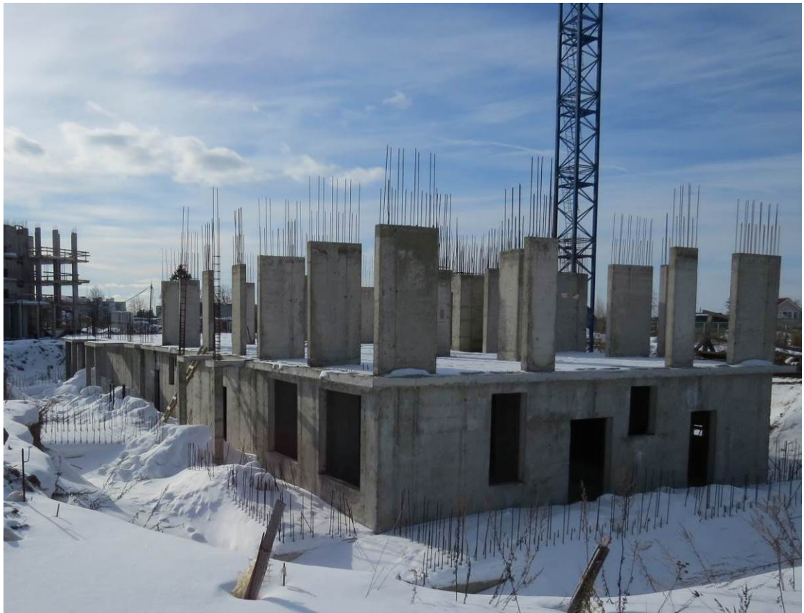
Рис. 1.3. Общий вид смонтированных конструкций по осям 28 и А жилого дома №23
