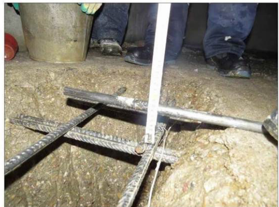
ФОТО 21. Замер толщины защитного слоя бетона монолитной железобетонной плиты перекрытия подвала на отм. ниже ±0.000 между осей Ж/8-9 (зона верхнего армирования)
