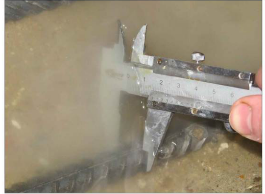
ФОТО 23. Уточнение диаметра арматуры монолитной железобетонной плиты перекрытия подвала на отм. ниже ±0.000 между осей Ж/8-9 (зона нижнего армирования)
