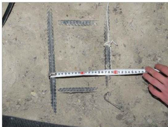
ФОТО 11. Общий вид вскрытия монолитной железобетонной фундаментной плиты на отм. -3.400 в осях А-Б/23-24
