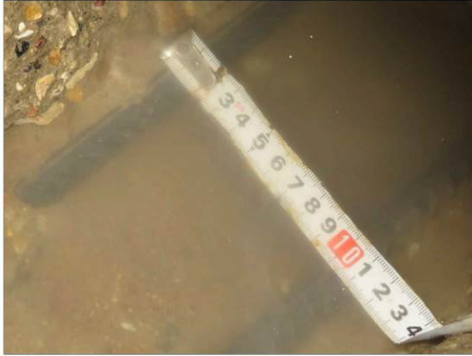
ФОТО 22. Общий вид вскрытия монолитной железобетонной плиты перекрытия подвала на отм. ниже ±0.000 между осей Ж/8-9 (вертикальный шаг, нижней сетки армирования)
