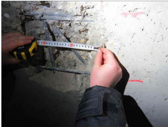
ФОТО 9. Общий вид вскрытия монолитной железобетонной стены на отм. выше ±0.000 в осях 24/В-Б
