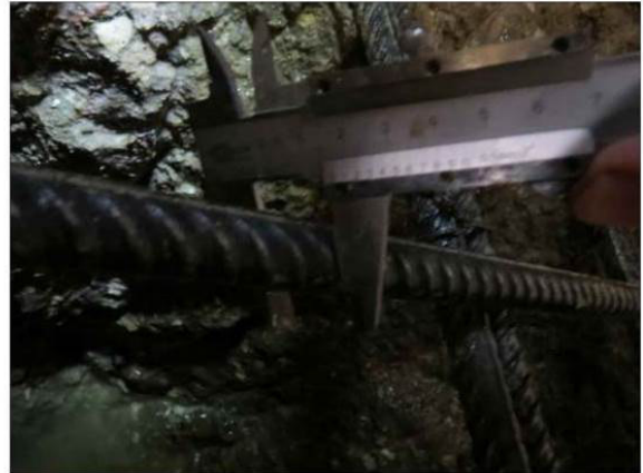
ФОТО 19. Уточнение диаметра арматуры монолитной железобетонной плиты перекрытия подвала на отм. ниже ±0.000 между осей Ж/8-9 (зона верхнего армирования)
