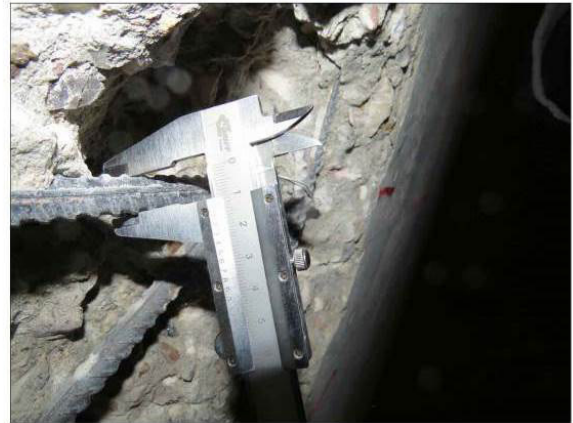
ФОТО 10. Уточнение диаметра арматуры монолитной железобетонной стены на отм. выше ±0.000 в осях 24/В-Б
