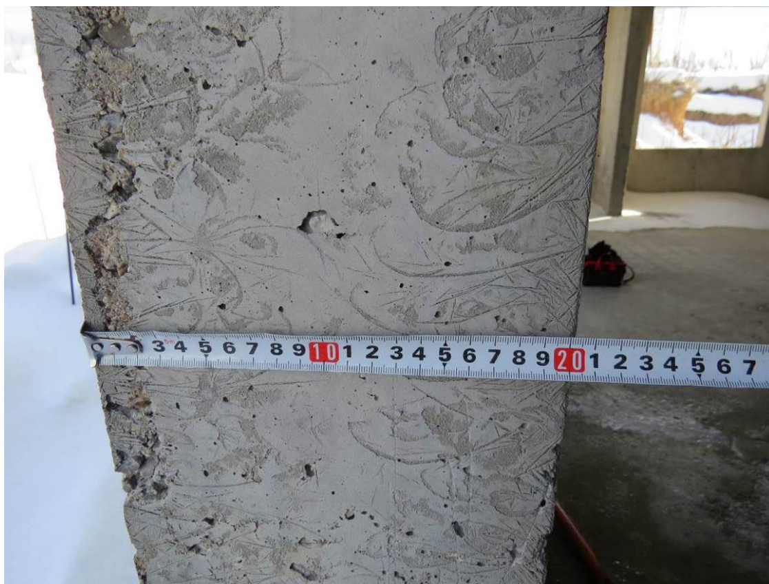
Рис. 3.2.2. Замер толщины монолитной ж.б. стены по оси 28/Б-В
