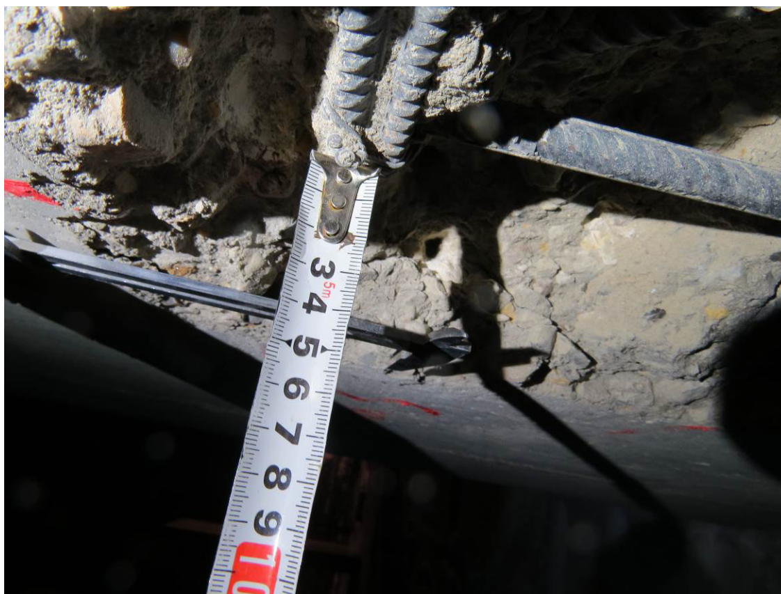
Рис. 3.2.7. Определение толщины защитного слоя бетона стены в участке вскрытия 3 в осях 24/Б-В в уровне 1го этажа
