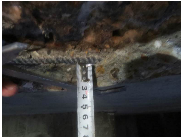
Рис. 3.3.8. Замер толщины защитного слоя бетона нижнего армирования плиты перекрытия подвала между осями А-Б/25-27
