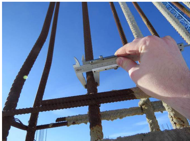
Рис. 3.2.12. Замер диаметра вертикального армирования пилона 1-го этажа на пересечении осей Б/25
