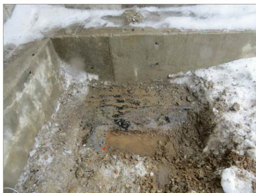
ФОТО 1. Общий вид внутреннего пространства шурфа №1 расположенного в осях Г/24-26
