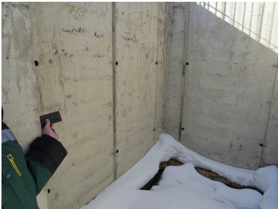
Рис. 2.4. Уточнение габаритов лифтовой шахты в уровне 1 этажа при помощи лазерного дальномера Leica DISTO D410
